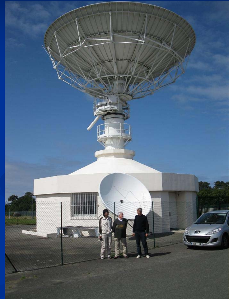
L'antenne PB8 de 13m et l'antenne équatoriale de 3m
