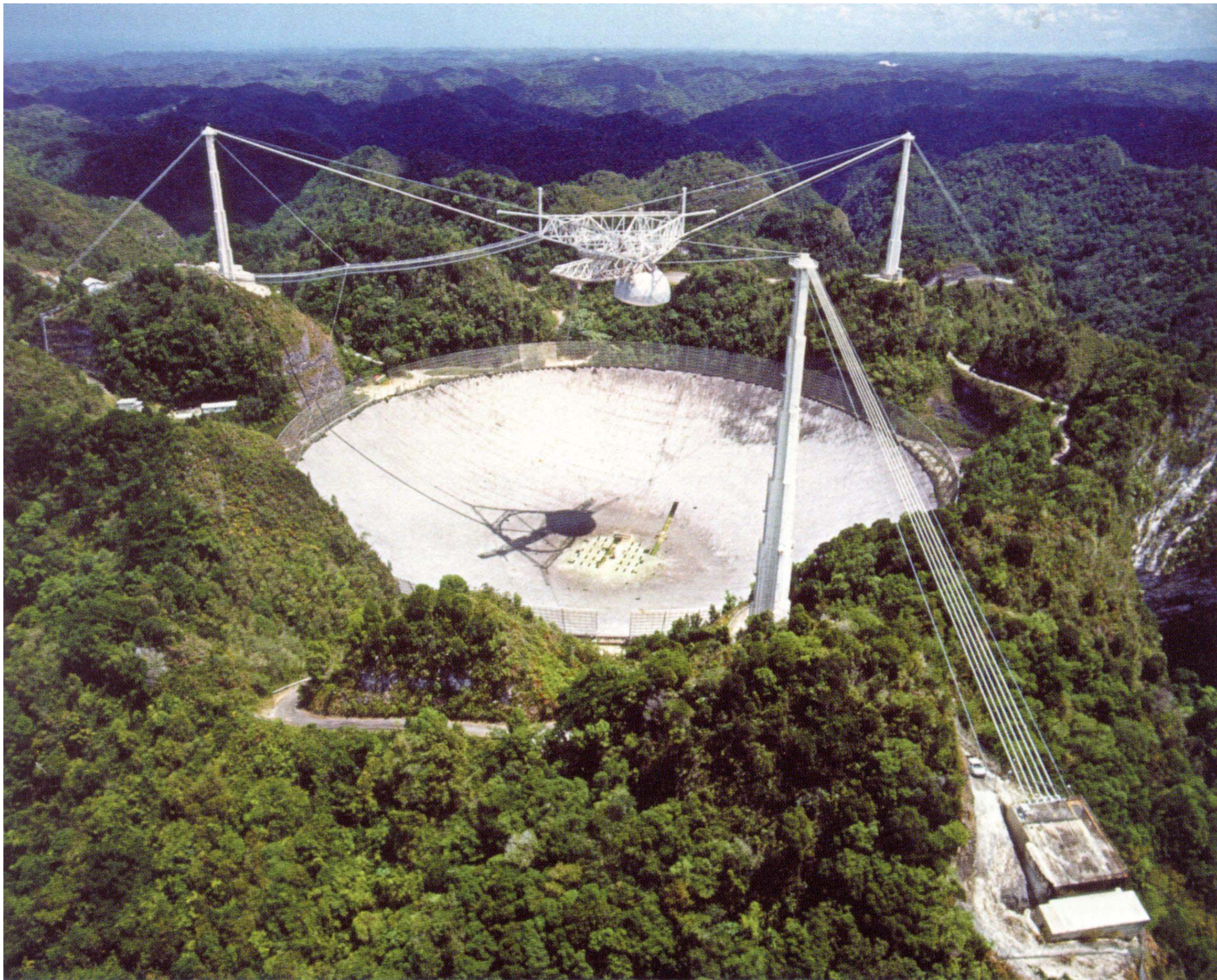
Radiotélescope d'Arecibo (Porto Rico - NSF USA), 1963 Antenne sphérique fixe diamètre 300m, observe jusqu'à 10000 MHz Images radar de planètes, pulsars, projet SETI
