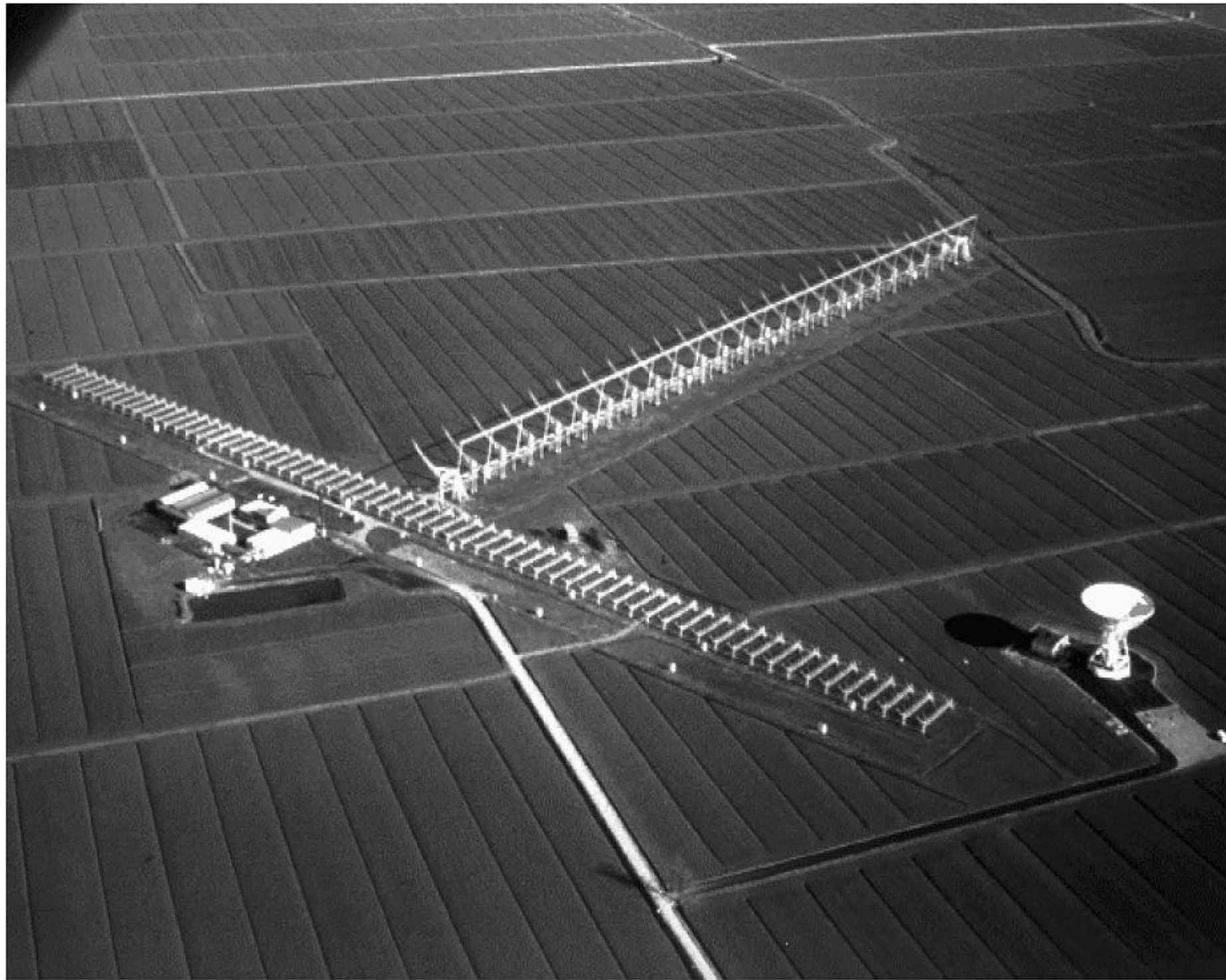
Observatoire de radioastronomie de Bologne(Italie), 1964 Croix de Mills, longueur des bras 600m, fréquence 408 MHz Etude des nuages interstellaires, pulsars...
